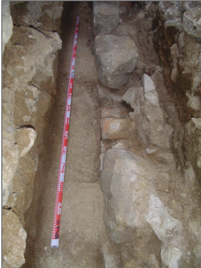
FOTOGRAFIA 9: Detall del mur de claveguera U.E. 9003 al carrer de l'Arc de Sant Silvestre núm. 3.
