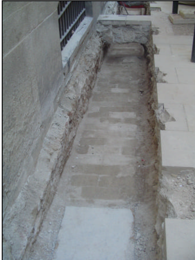
FOTOGRAFIA 1: Detall de la rasa 1000, on es pot observar la coberta del col·lector.
