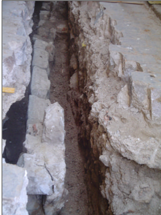
FOTOGRAFIA 8: Detall del mur de claveguera U.E. 9003 al tram del carrer de l'Arc de Sant Silvestre amb la Plaça de Santa Caterina.
